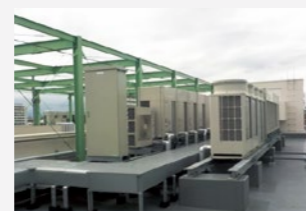
空調設備改修工事
