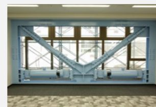
耐震補強工事
