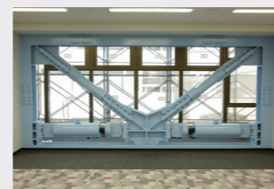
耐震補強工事
