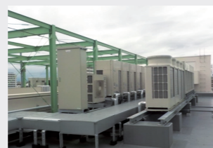
空調設備改修工事
