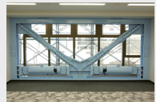
耐震補強工事
