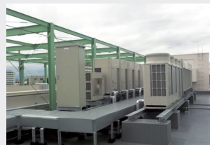
空調設備改修工事
