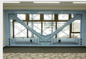
耐震補強工事
