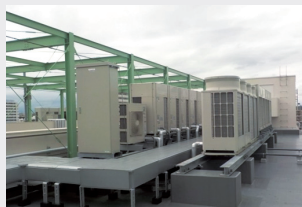
空調設備改修工事
