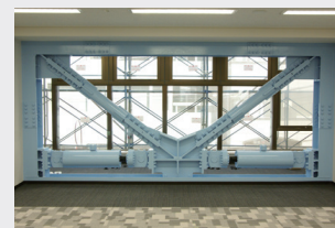
耐震補強工事
