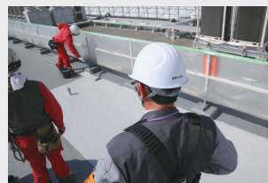
屋上防水工事
